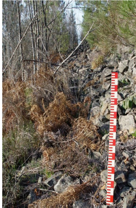
Fig. 3 – Derrube de muralha do povoado
